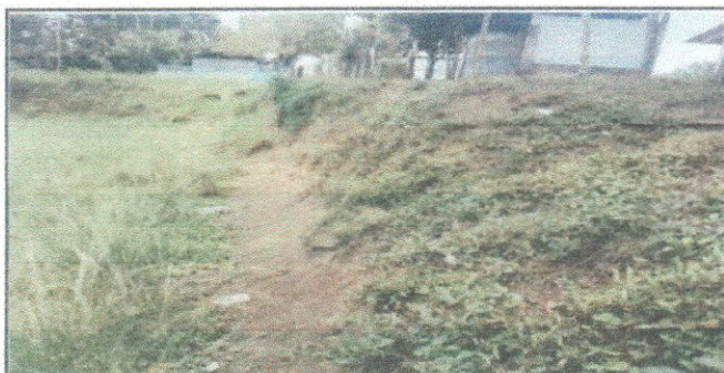
Foto 5: Se observa el cerco perimetral de la Escuela en mal estado
